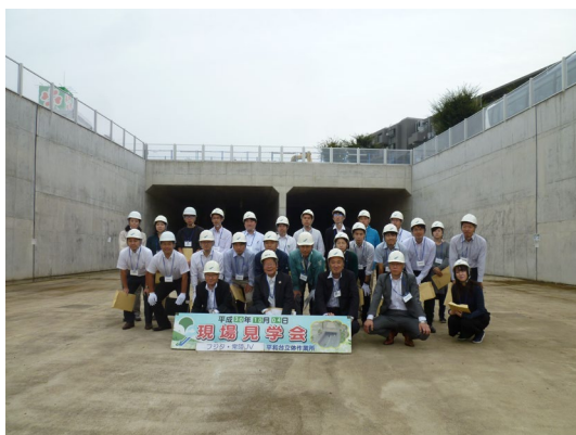
放35環8立体交差部にて
