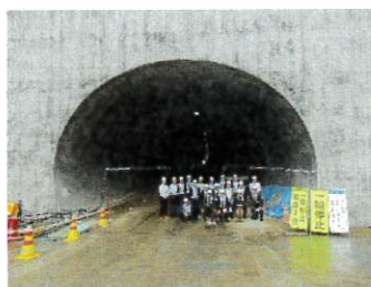
芝山工事（発進側坑口）
